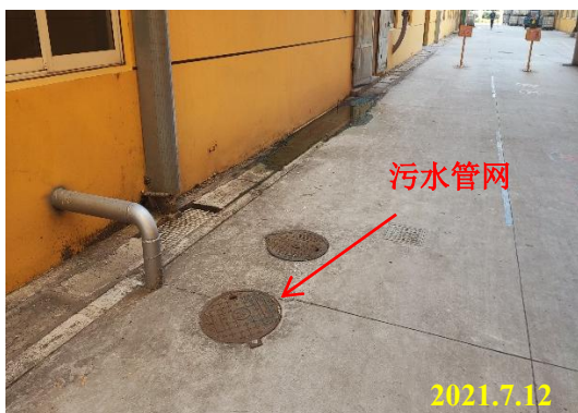
图 3-3 项目区中部污水管网
