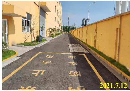
图 1-9 项目消防应急通道 2
