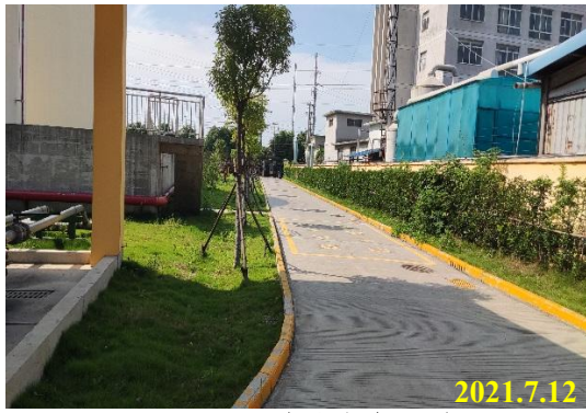
图 1-8 项目消防应急通道 1
