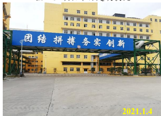
图 1-5 建筑物区现状 1
