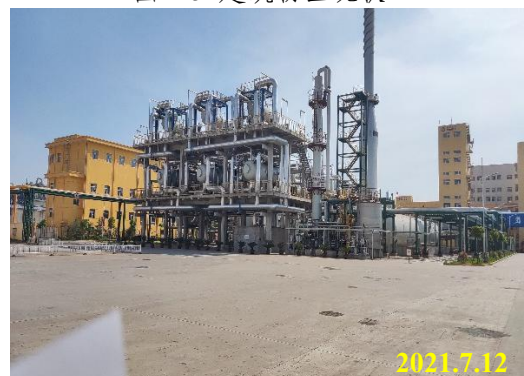
图 1-7 建筑物区现状 3
