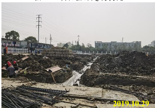
图 1-4 项目东区建设状况
