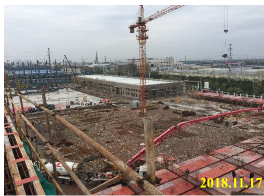
图 1-3 项目中部建设状况
