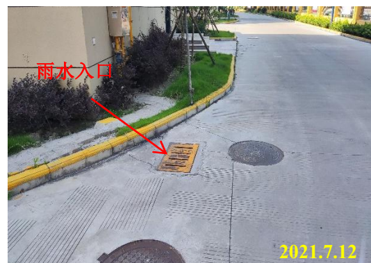
图 3-4 项目区东侧雨水入口
