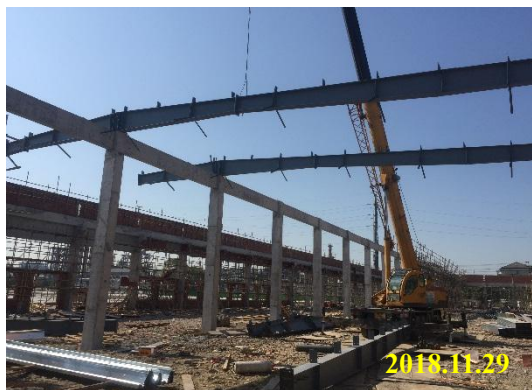
图 1-2 项目西部建设状况
