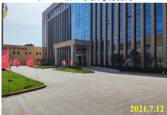
图 1-6 建筑物区现状 2
