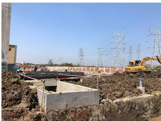
图 1-9 变电站回土及围墙建设
